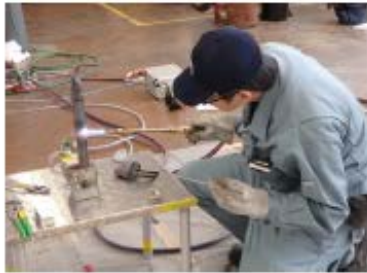
⑤ 鋼管ろう付作業
