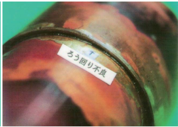
写真(i) ろう周り不良
