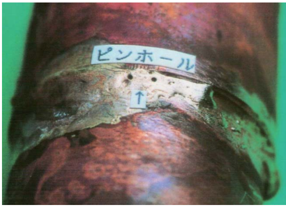
写真(h) ピンホール
