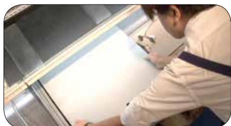
ショーケースの床板をはずします。
