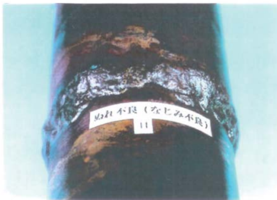
写真 (f) ぬれ不良 (なじみ不良)
