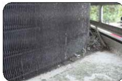
熱交換器下部の腐食
