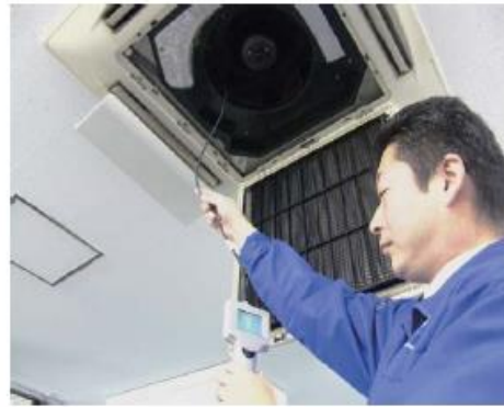
図 B.20 室内機の内部点検（例 2）
