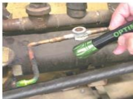
図 B.15 蛍光剤法による検知例 (2)
