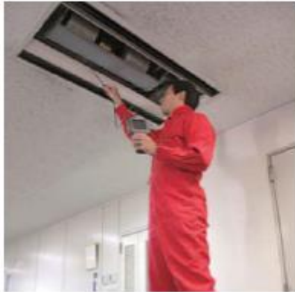
図 B.19 室内機の内部点検（例 1）
