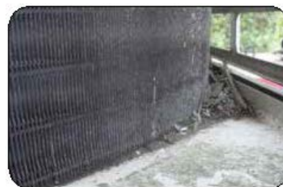
熱交換器下部の腐食
