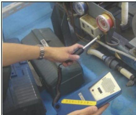
直接法による点検
