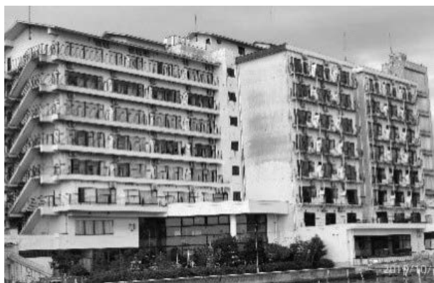
写真 9 屋外機設置状況
