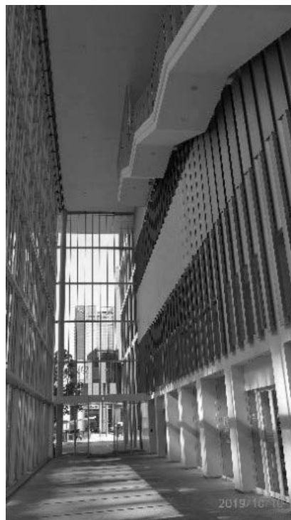
写真2 エントランスホール
