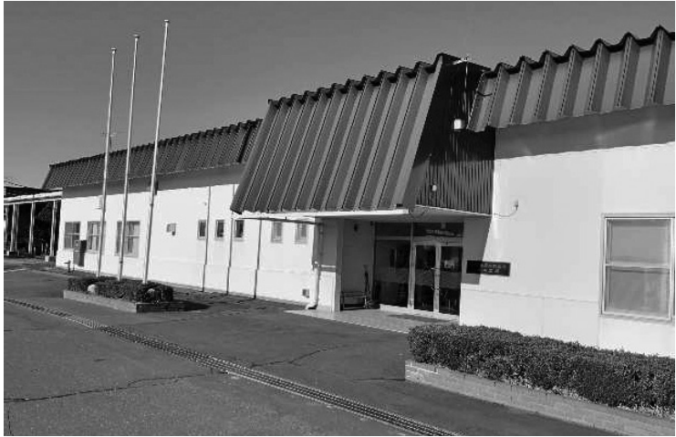
釧路工場 FN 工場建物外観
