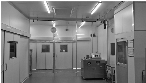
クリーンルーム外観
