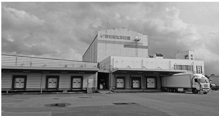
穂波第1センター外観
