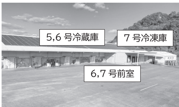
図1 穂波第1センター 冷凍倉庫写真
