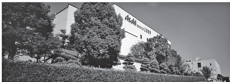
アサヒビール吹田工場外観
