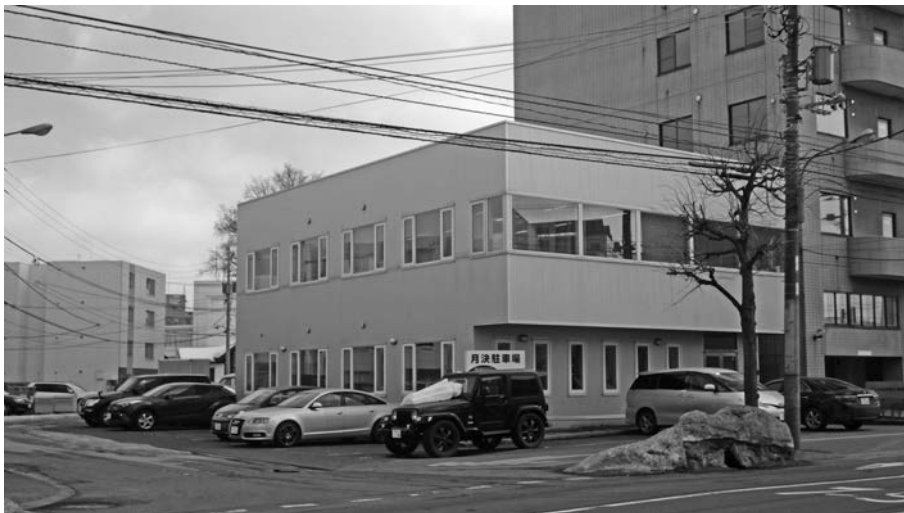
アルミ冷媒配管導入事務所
