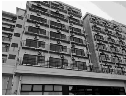
室外機設置状況
