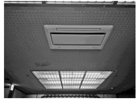
室内機設置状況
