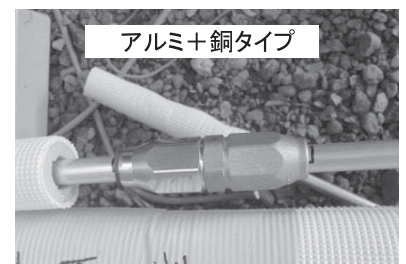
写真5 機器廻り施工状況
