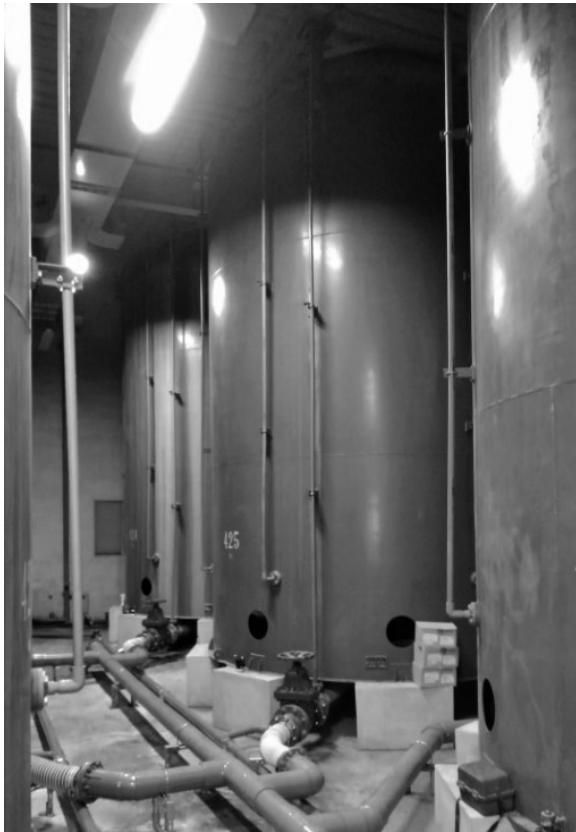
ジャケット熱交換器導入前（醗酵タンク）
