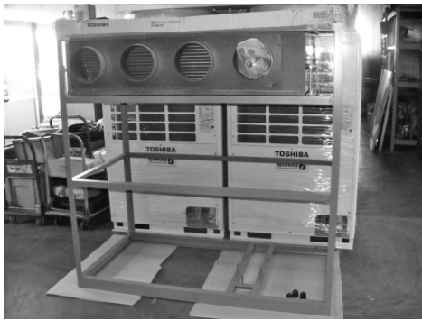
写真1 架台製作中
