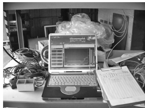
写真6 試運転調整データ収集中
