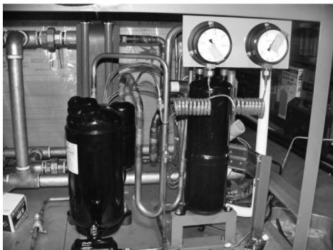
写真3 冷媒・水配管完了 気密試験中
