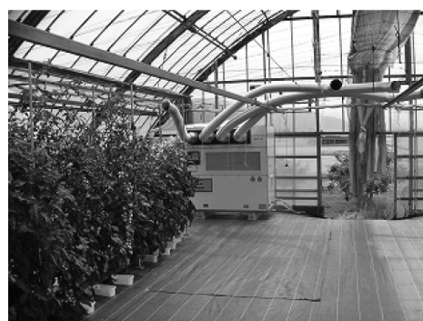
写真10 設置工事完了
