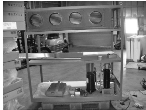
写真2 空気熱交換器取付中
