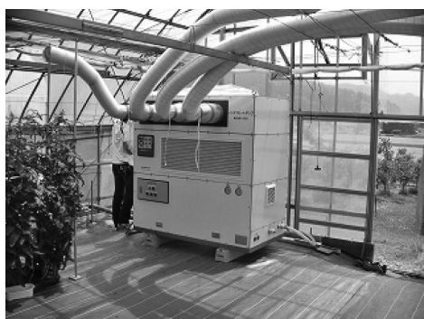
写真9 ダクト設備工事完了
