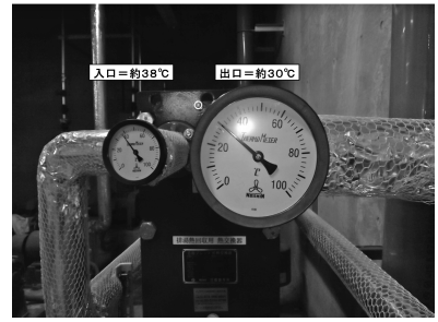
図3 一次側排湯熱回収温度
