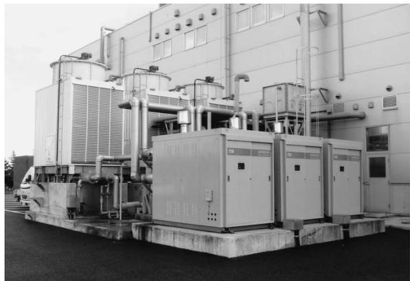
図8 吸収冷温水機と冷却塔
