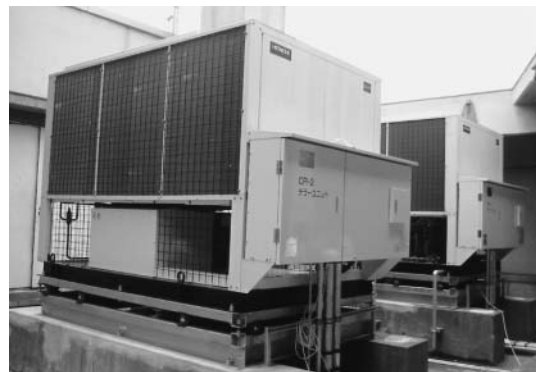
図3 大温度差変流量対応空冷HPチラー
