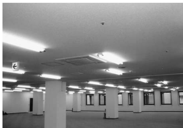
写真2 改修後のフロアー
