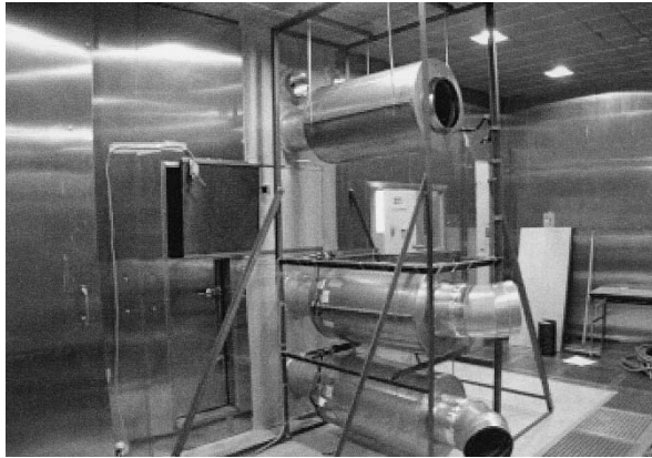
給気ファン(弊社試験室にて事前に特性測定を行なっている様子)
