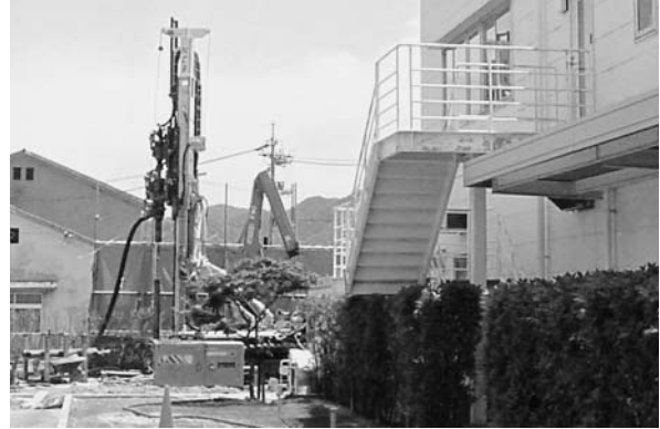
杭熱交換器 ボーリング状況
