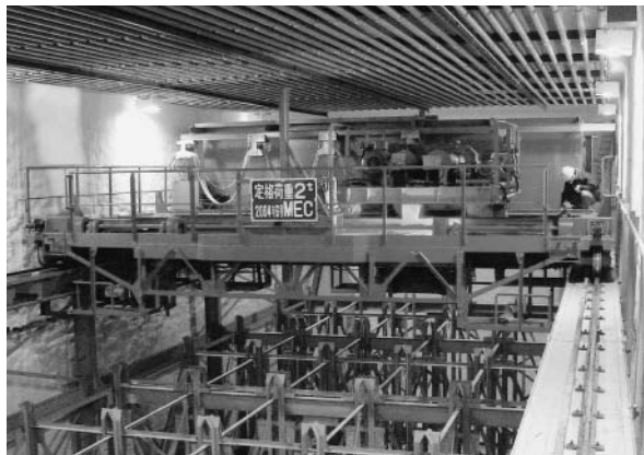
図1 天井コイルと自動クレーン
