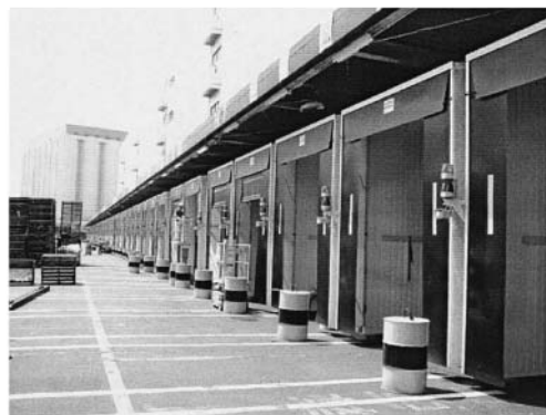
東京水産ターミナル(株)4号棟 (44組設置)
