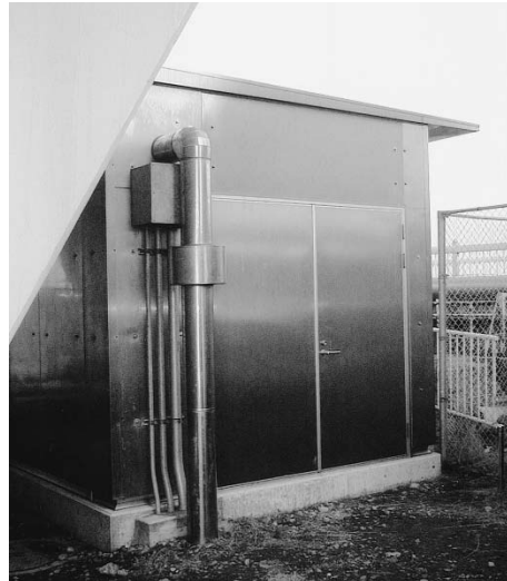
ヒートポンプ機械室全景
