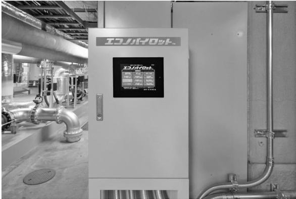
写真3 冷温水2次ポンプ 省エネ制御システムの制御盤外観
