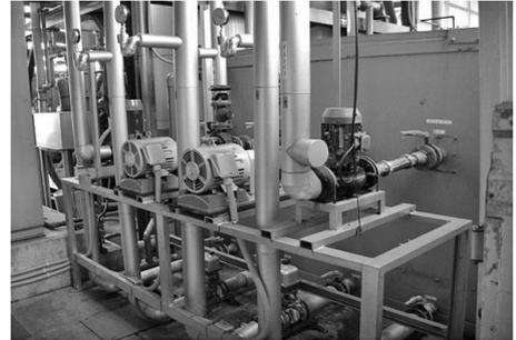
写真2 冷水循環ポンプ設置状況
