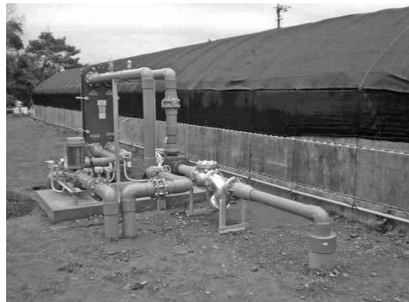
井戸ポンプ及びプレート式熱交換器 揚水量800L/min
