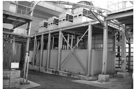
写真3 蓄熱アイスチラーおよび冷凍機設置状況
