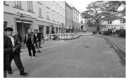
写真11 冷房用埋設管の工事現場
