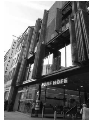
写真12 自動日よけシャッター
