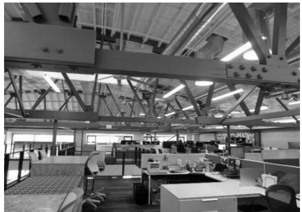
鉄骨が見える事務所エリア
