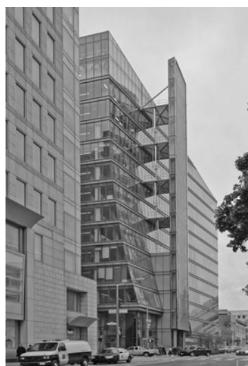
写真5 SF PUCビルの壁面風力発電装置
