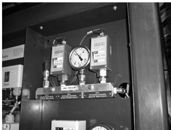
高圧部分圧力計：57bar
