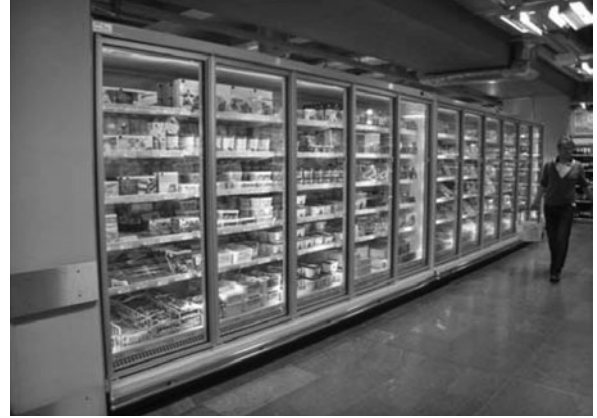
写真10 4台連結では中央の連結部分に仕切りが入る
