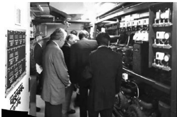
写真3 機械室内の視察状況
