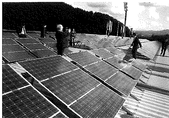
写真7 サッカー場の観客席上部に設けられた太陽光発電パネル
