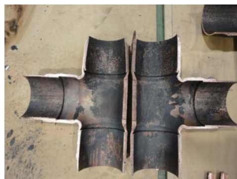
⑥ チーズ部切断面（銅管差し込み不足の例）
