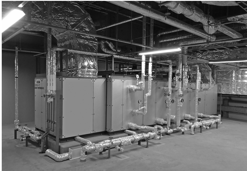
自己再熱型外気処理調和機
