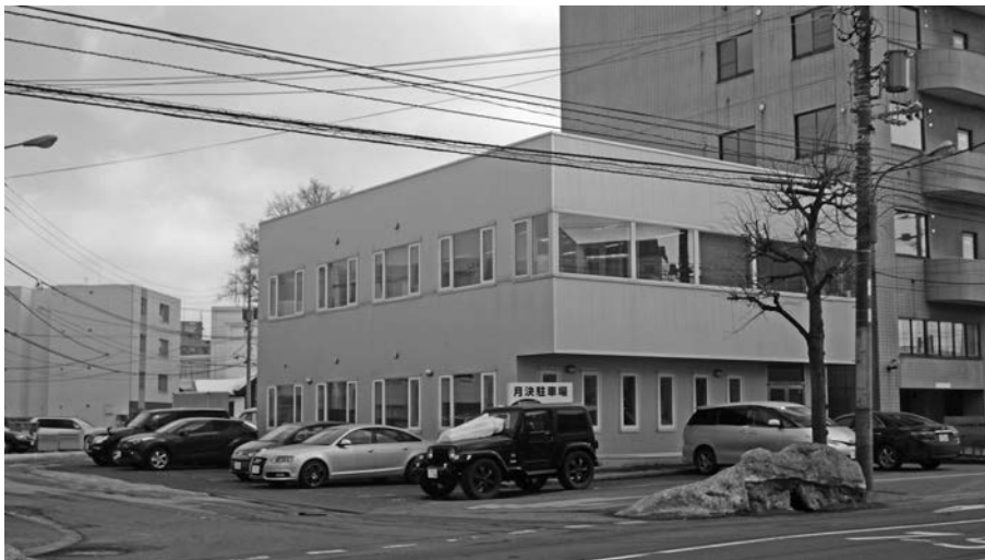
アルミ冷媒配管導入事務所
