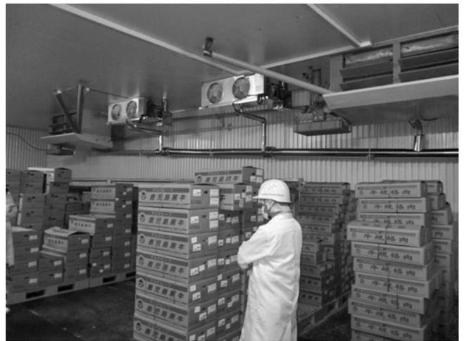
写真3 牛製品保管庫（既設機器（庫内側面）、更新機器（庫内中央））
