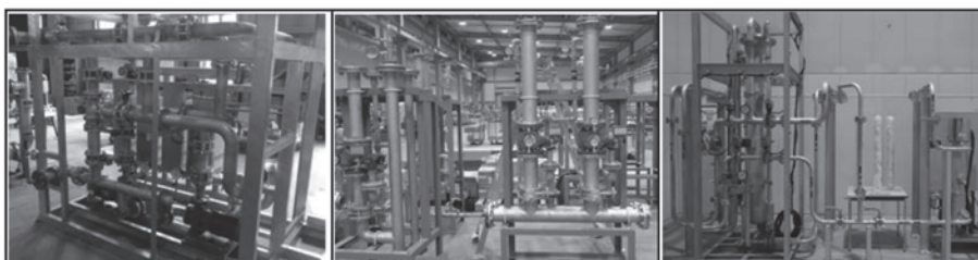
写真5 プレハブ配管、ポンプ・機械周りユニット例
