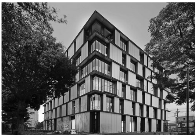
建物外観（南西より）
