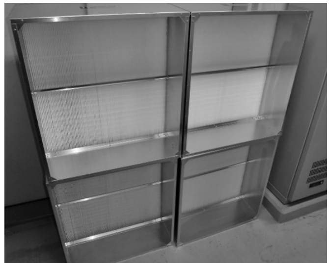
写真4 改善後 (洗浄可能低圧損フィルタ)
