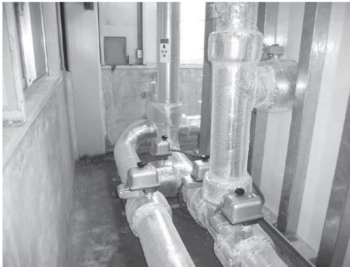
流れ方向切り替 え用電動弁
