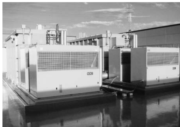
ウルトラ エコ・アイス システム蓄熱ユニット外観
