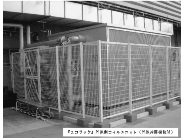
図4 『エコラック』外気側コイルユニット（外気冷房機能付）
