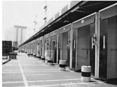
東京水産ターミナル(株)4号棟 (44組設置)
