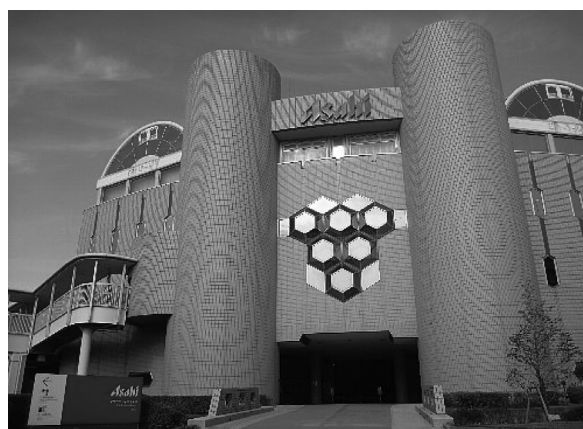
アサヒビール株式会社博多工場 外観
