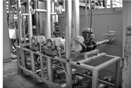
写真2 冷水循環ポンプ設置状況
