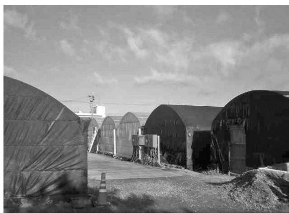
養鰻池 (100~150坪/池) 事業場内 17池
