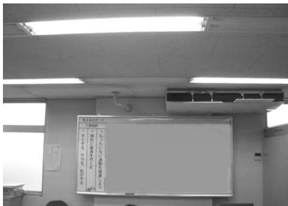
写真2 空調機移設後 (横並びに2台あったものを、1台移設した。)
