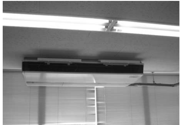
写真3 移設した空調機内機
