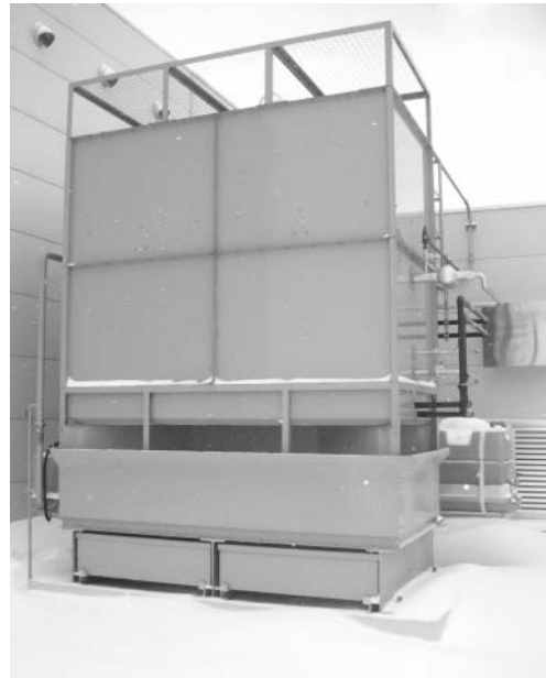
写真3 エバコン（蒸発式凝縮器）外観
