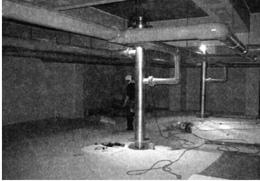
図5 蓄熱槽内部（誘導管設置状況）
