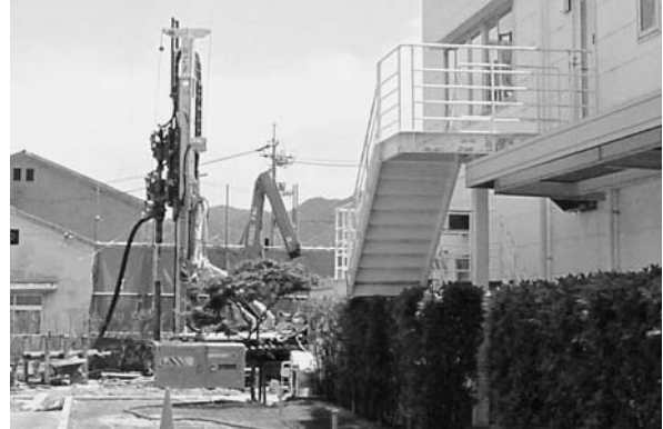
杭熱交換器 ボーリング状況
