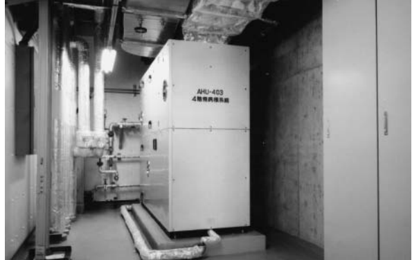
空冷ヒートポンプ式熱回収外調機 外観
