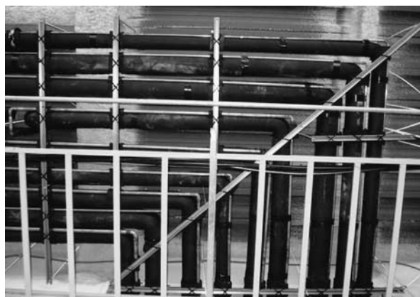
天井配管の支持・保護の様子
